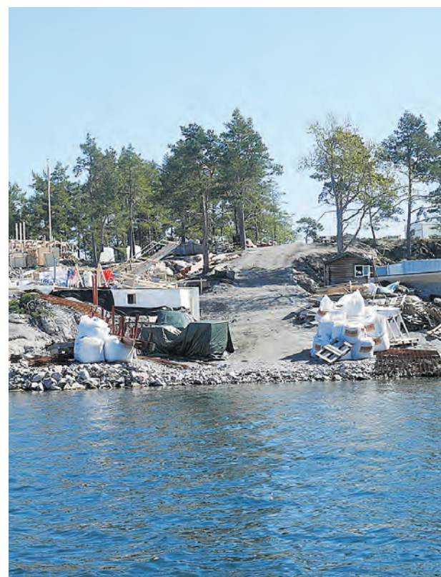
En väg har anlagts tvärs över ön för att maskiner och material ska kunna transporteras.
