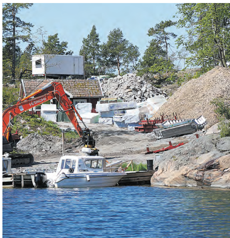
Stora högar med sprängsten och flis har lagts upp på tomten. Bilden tagen från öns östra sida, där fastighetsägaren vill ersätta två befintliga hus med nya större byggnader samt anlägga en större brygga.
